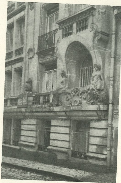
Fenêtre sous balcon en surplomb
