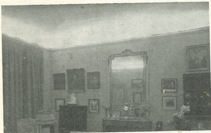
Salon de M. G. — Eclairé par corniches garnies de 95 lampes Linolites de 25 watts en gouttière aluminium. La surface du salon est de 27 m 2 . L'éclairement horizontal à 80 cm. du sol, est de 25 lux au centre de la pièce. La consommation totale est de 25 ampères,
