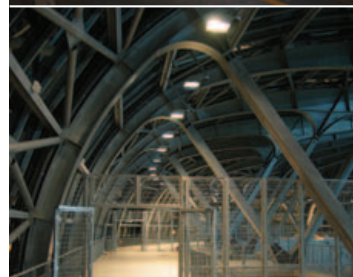
LumiVille 2008 : le prix « Patrimoine bâti »
