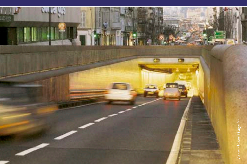
Tunnel Espace intérieur Lampe au sodium haute pression 150 ou 250 W Tunnel Dame Joliette, Marseille (13)
