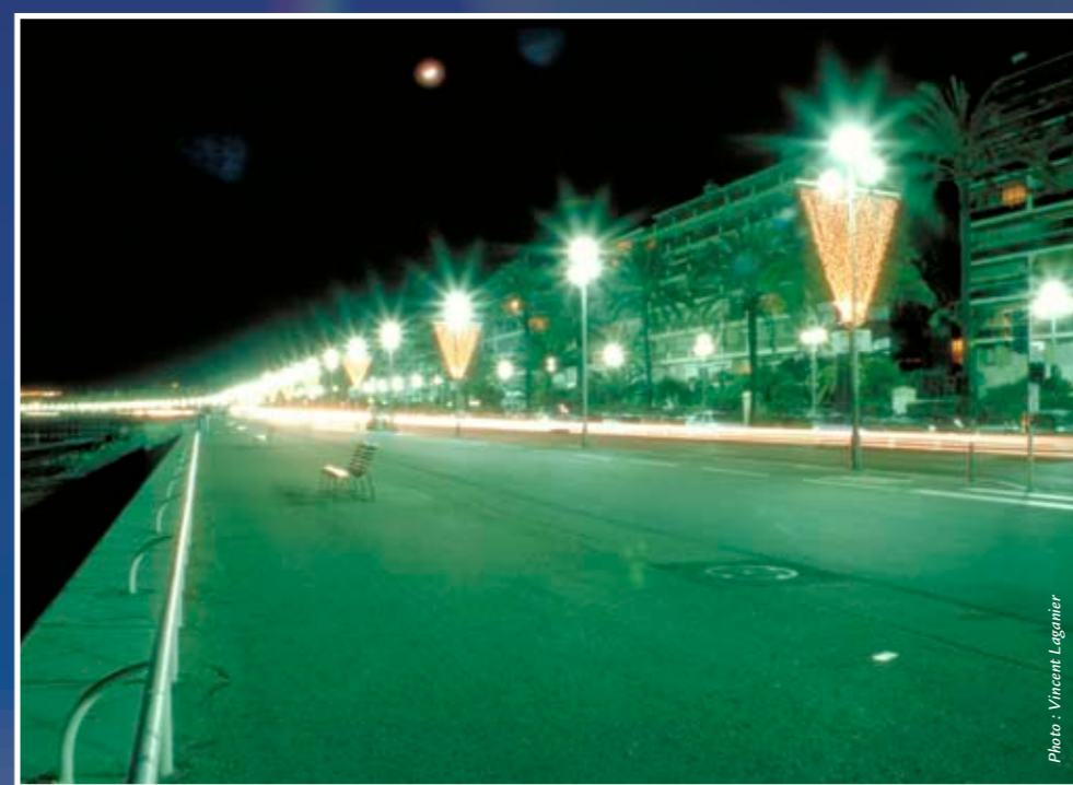
Bord de mer Avenue et trottoirs Ballon fluorescent 3 x 400 W Promenade des Anglais, Nice (06)
