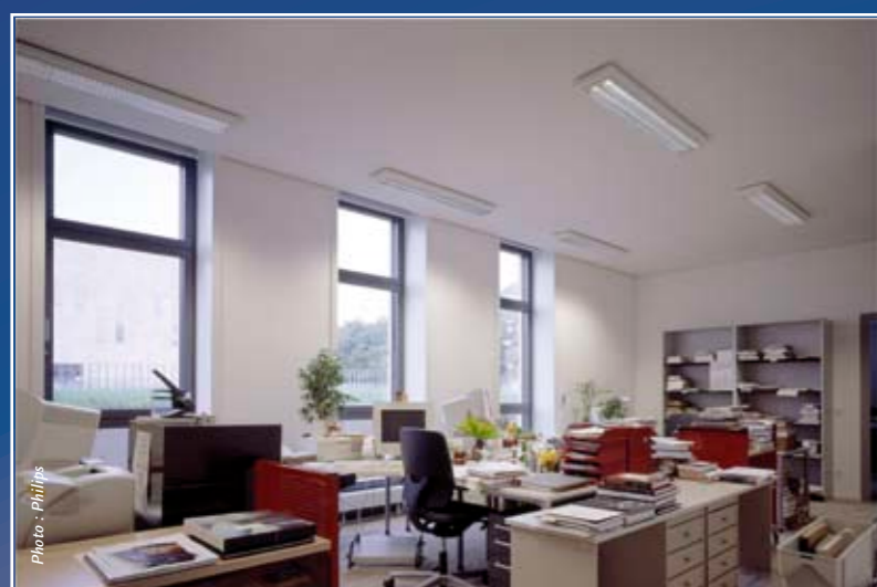
Bureau Espace de travail Tubes fluorescents 14 ou 36 W
