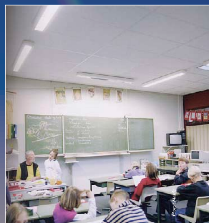
Ecole Salle de cours Tubes fluorescents 2 x 36 W
